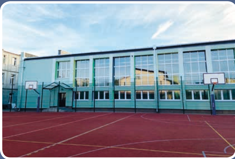
Termomodernizacja i remont budynku Zespołu Szkół Ponadpodstawowych nr 1 w Łasku
