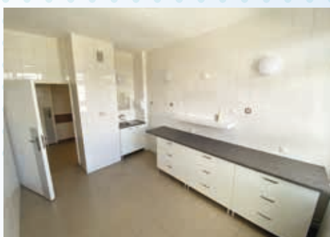
Remont Oddziału Chirurgii Ogólnej oraz Oddziału Chirurgii Szczękowej i Laryngologii wyremontowany przez spółkę „Szpitale Powiatowe”
